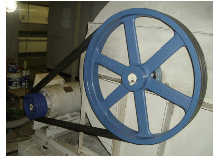
プーリー交換後
