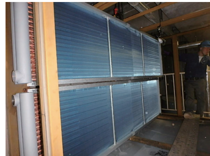
コイル入替完了
