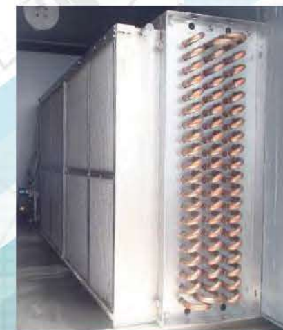
熱交換器の取り外し・新規熱交換器設置施工
