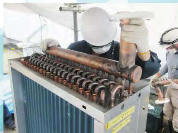
取り付け仕上げ加工
