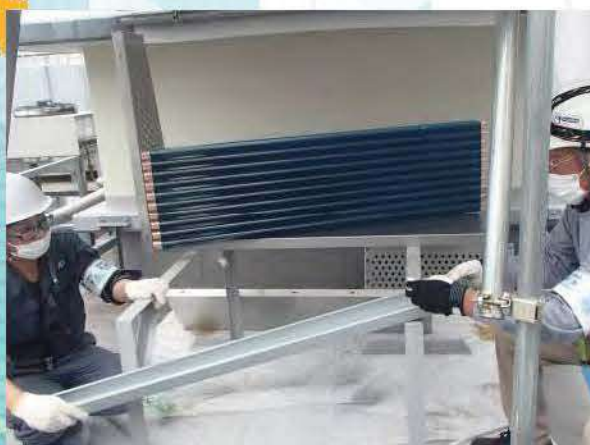
現地施工風景
