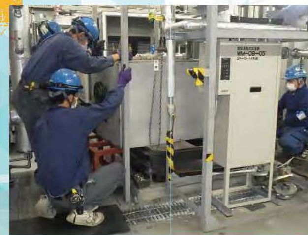
空調機の取り外し・設置施工風景
