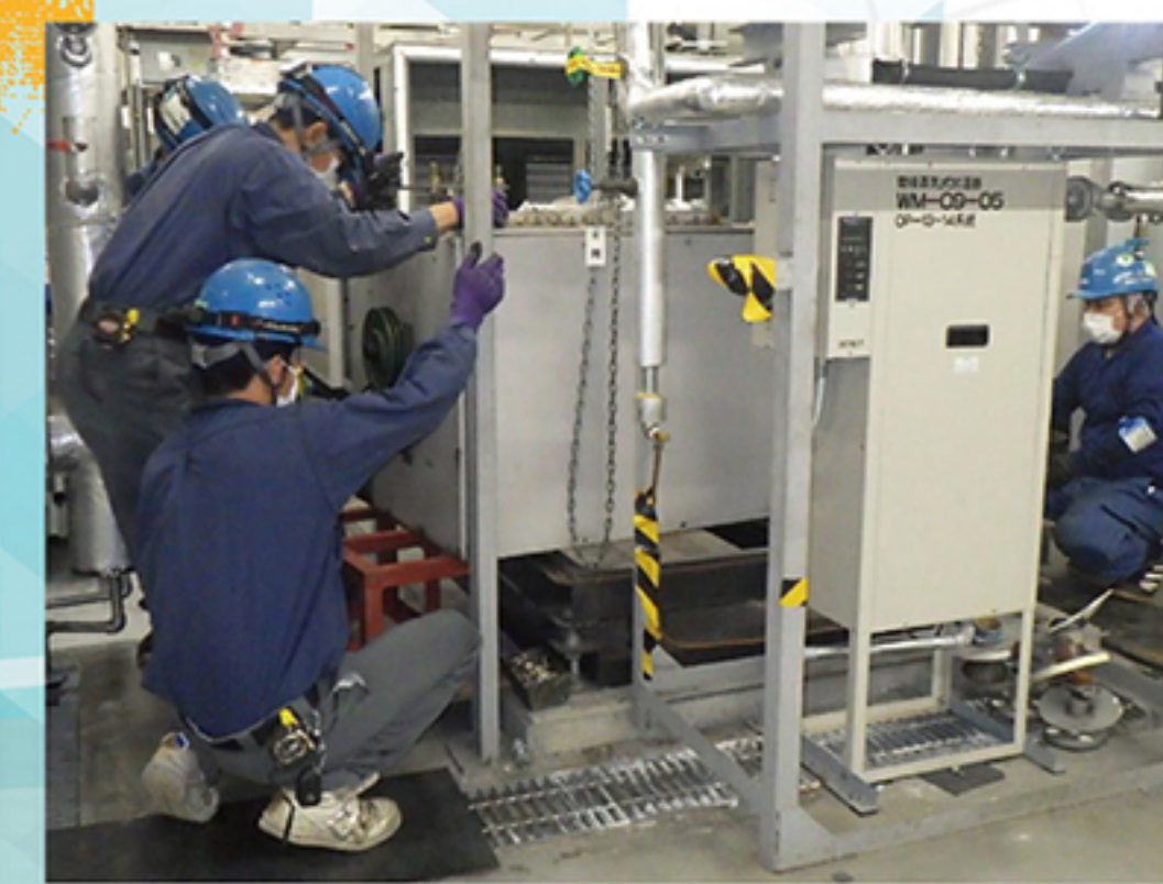
空調機の取り外し・設置施工風景
