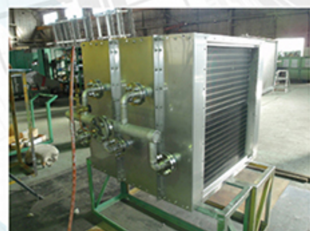
ダクト型SUS管蒸気コイル
