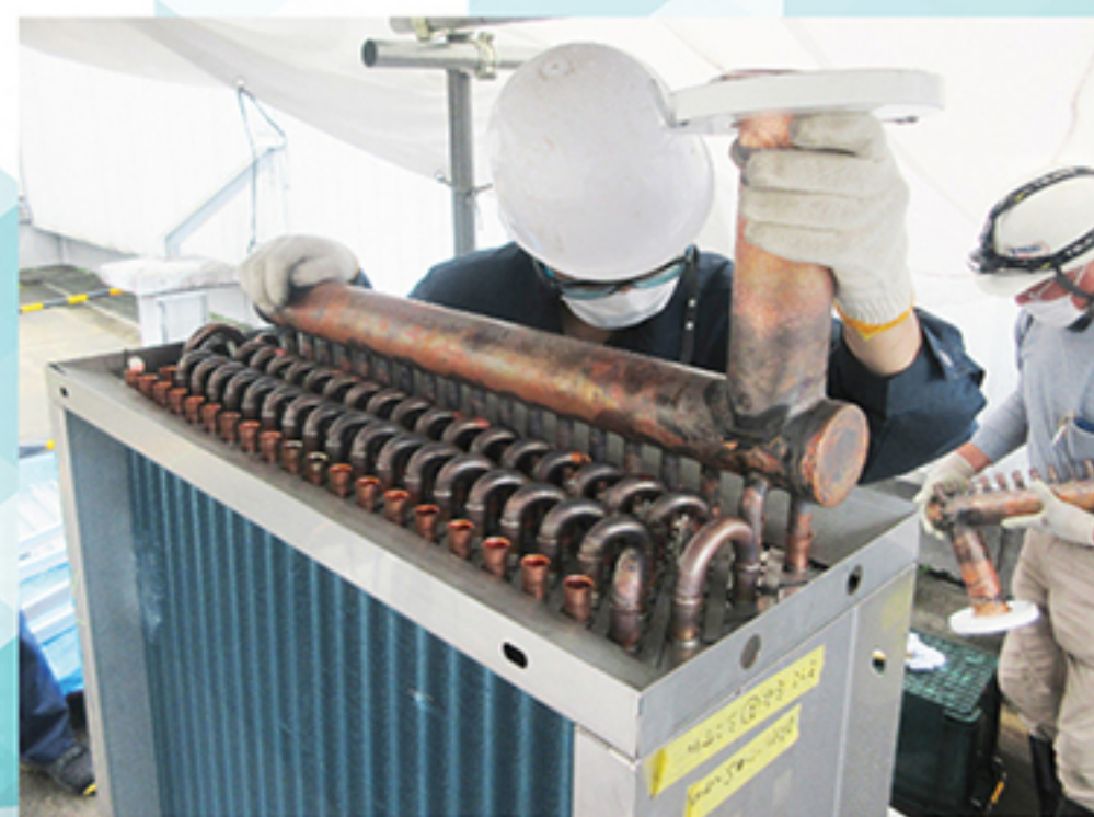
取り付け仕上げ加工
