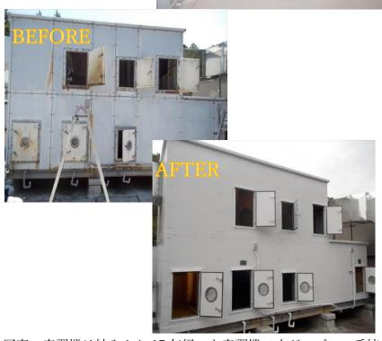
写真の空調機は納入から17年経った空調機ですが、プール系統の空気も循環もしているので腐食具合も他の空調機より激しいです。
